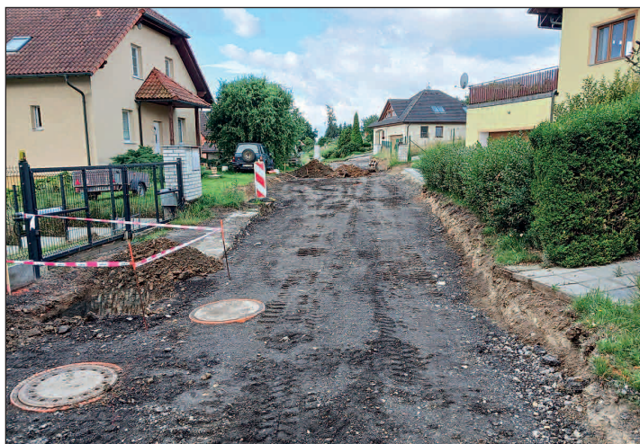
Rekonstrukce ulice Na Borku je v plném proudu
