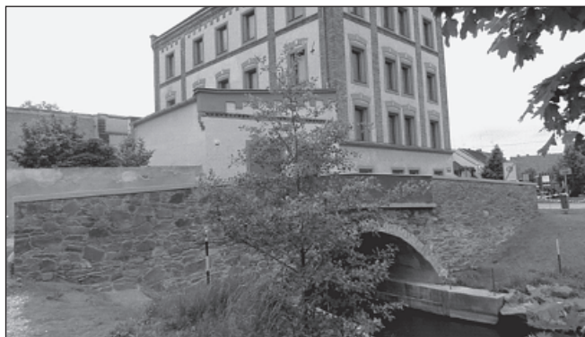
Most po rekonstrukci
