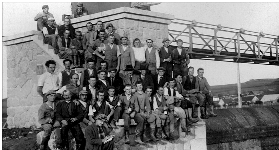
Stavitelé regulace řeky na novém jezu proti nádraží
