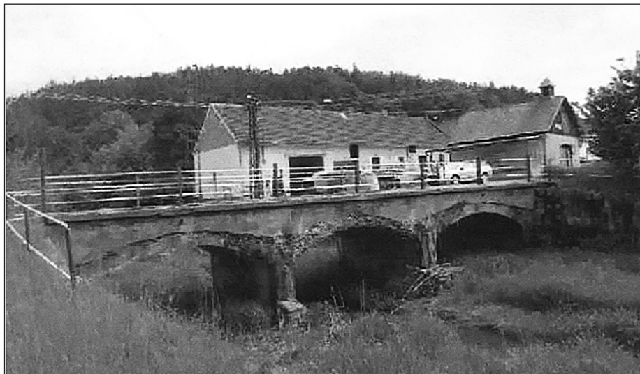
Dosluhující most v Kokšíně
