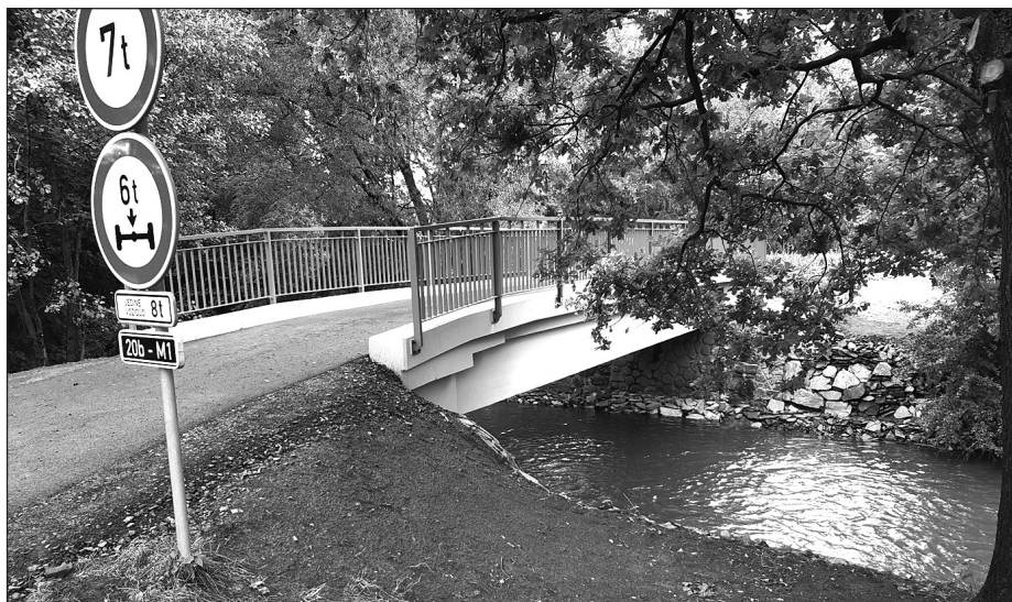
Dokončený most v Jíně
