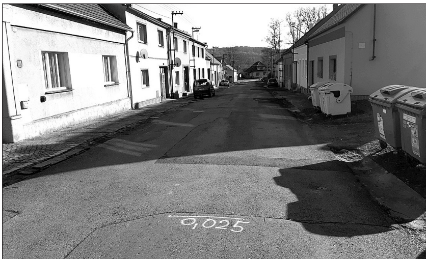
Tyršova ulice před rekonstrukcí
