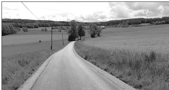
Opravená místní komunikace v Kamýku
