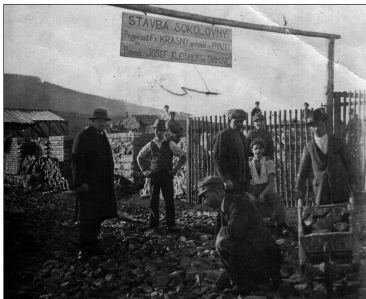
Stavba sokolovny právě začala (jaro 1925)
