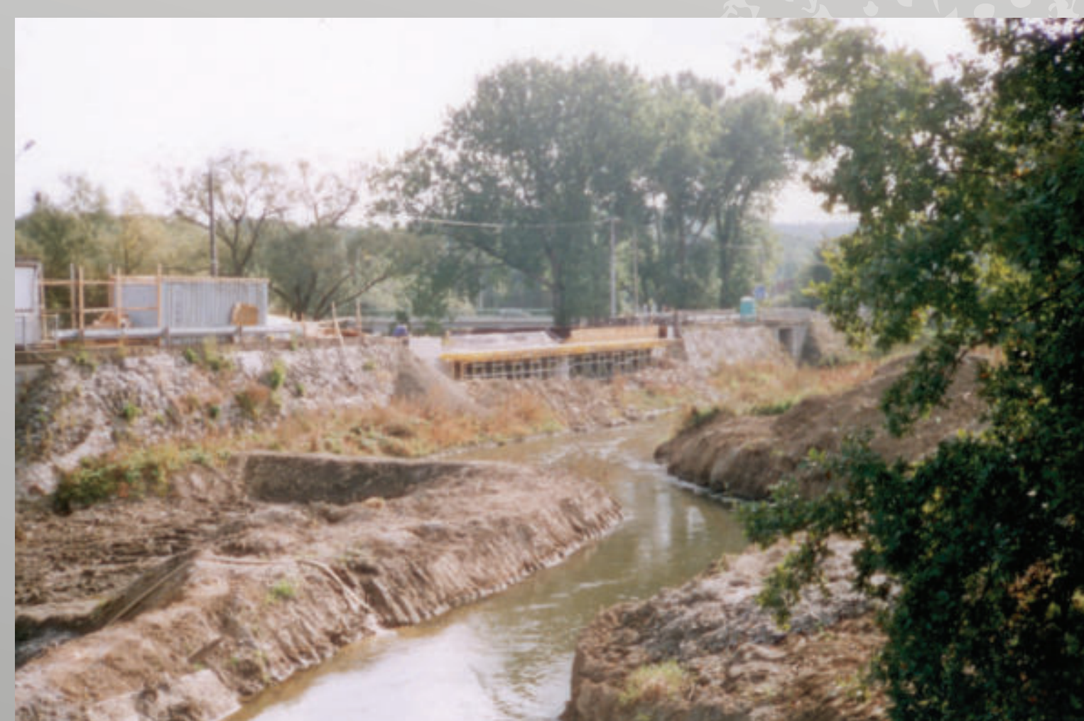
Inundační most postavený v roce 2004
