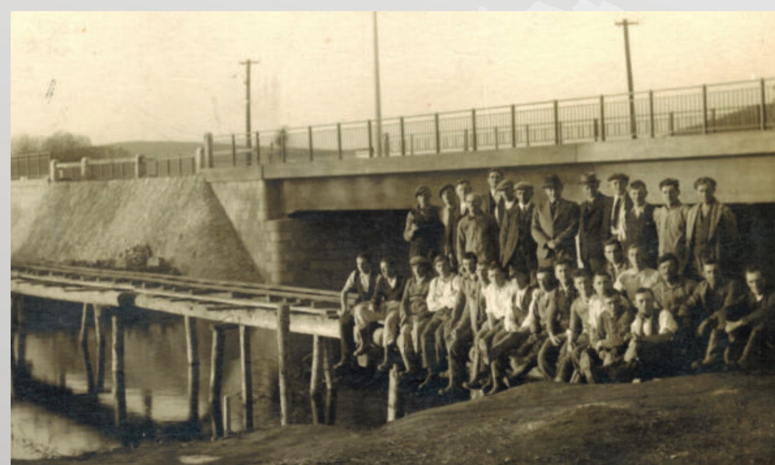
Dokončení nového mostu (podzim 1937)
