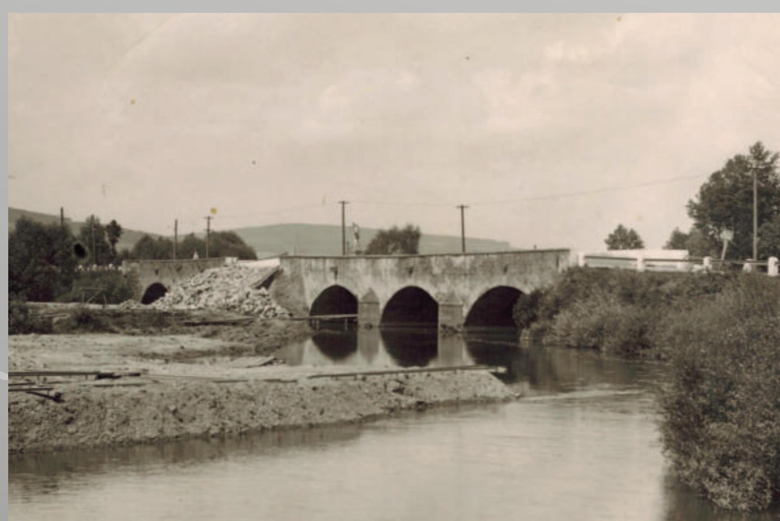
Začátek demolice mostu z r. 1811 (léto 1936)
